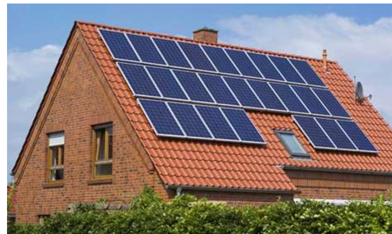
PANNEAUX SOLAIRES ACTIFS EN CELLULES PHOTOVOLTAÏQUES SUR TOIT
